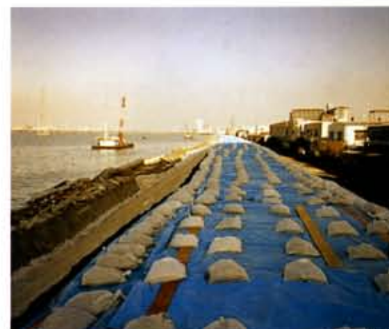
緊急復旧状況
