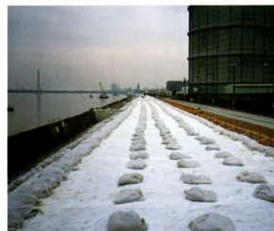
緊急復旧状況
