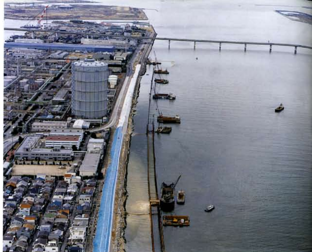
緊急復旧状況
