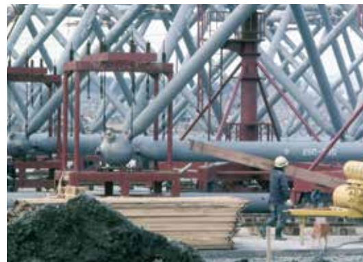
工事中の大屋根(大架構) (提供:大阪府)
