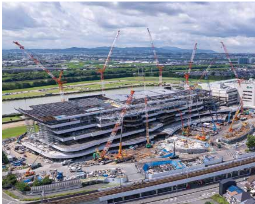
クレーンの設置台数を当初計画の8台から13台に増やし、クレーン設置期間を長くすることで工期短縮を図った。
