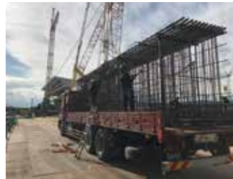
ユニット化した基礎梁配筋をトラックで運び、クレーンで設置することで工期を短縮。
