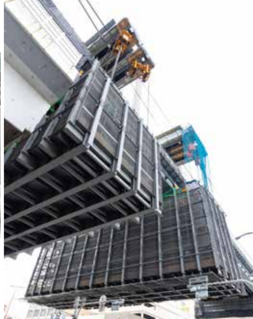
(右) 仮設桁から吊るされた移動作業車で既設の高速道路を解体していく。 (上) 移動作業車で分割・切断された既設コンクリート橋。 (左) 切断されたコンクリート橋撤去のために、既設高速道路に設置されたクレーン。
