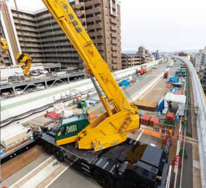
(右) 仮設桁から吊るされた移動作業車で既設の高速道路を解体していく。 (上) 移動作業車で分割・切断された既設コンクリート橋。 (左) 切断されたコンクリート橋撤去のために、既設高速道路に設置されたクレーン。
