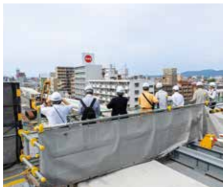
仮設桁の最上部から工事現場を視察する取材班。
