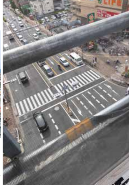
仮設桁から望む長居公園通り。車の往來の頻繁な交差点上空での作業を実感する。
