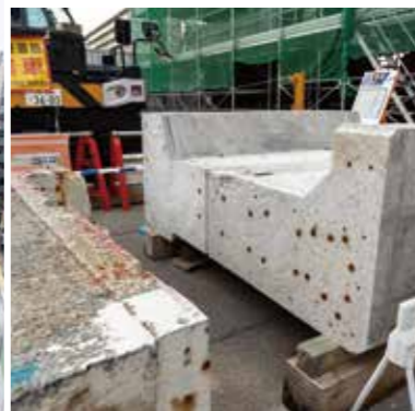
(右) 仮設桁から吊るされた移動作業車で既設の高速道路を解体していく。 (上) 移動作業車で分割・切断された既設コンクリート橋。 (左) 切断されたコンクリート橋撤去のために、既設高速道路に設置されたクレーン。
