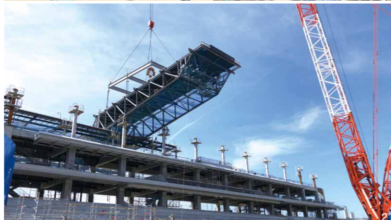
1.2. フィールド内で分割した大屋根を地組し、大型クレーンで設置
