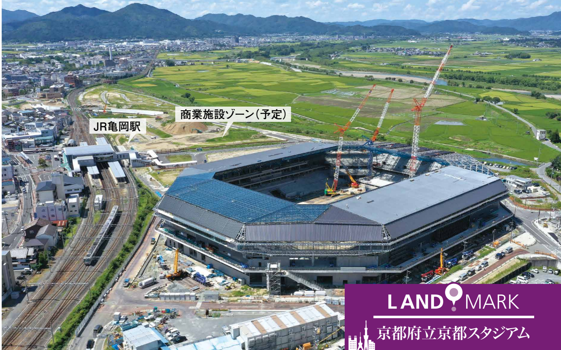
3.4. 基礎や地上躯体にプレキャスト部材を大々的に採用し、省力化・作業の効率化を実現
