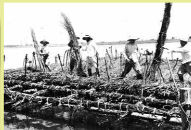
(左) 枝を組み上げた工物「粗朶沈床」 (右) オランダ語の「ケレップ(水制)」から、粗朶沈床を使った工法をケレップ水制とも呼ぶ。 写真提供：淀川河川事務所
