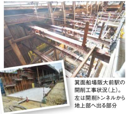
箕面船場大前駅の開削工事状況(上)。左は開削トンネルから地上部へ出る部分
