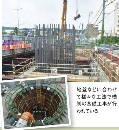
地盤などに合わせて様々な工法で橋脚の基礎工事が行われている
