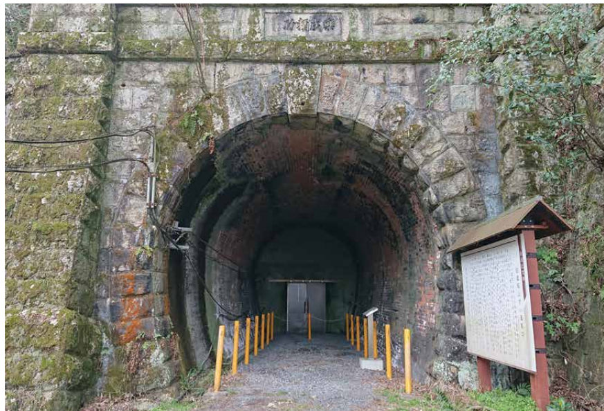
現在は東側隧道口のみが残っている。
