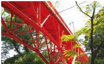
橋脚がトラス構造になったトレススル橋
