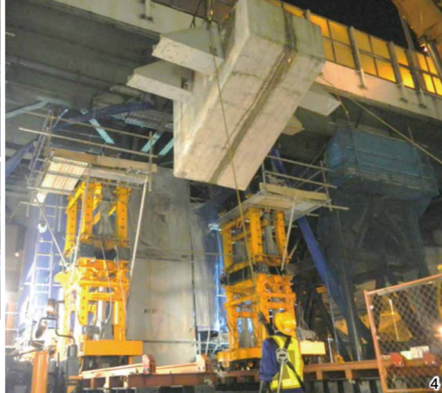
1.信濃橋渡り線の桁を架ける 2.上空制限下での施工 3.環状線の拡幅工事で既設橋脚と接合完了 4.切断した既設橋脚梁の撤去作業 5.6.幹線道路を夜間全面通行止めにして40m近い鋼桁を一括撤去
