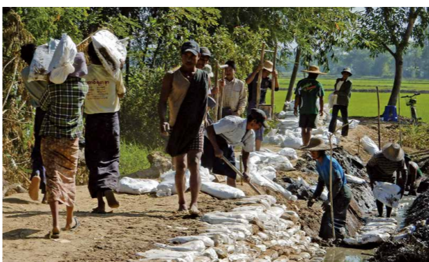
「道普請人」の指導のもと、地元の人々が生活道路を整備している様子。（写真はミャンマー）
