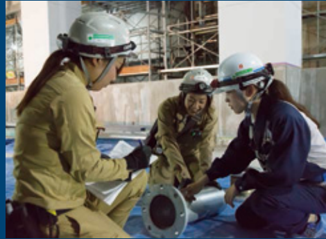
配管のサイズや溶接の仕上がりをミリ単位でチェック。 女性ならではのきめ細かさに定評あり。
