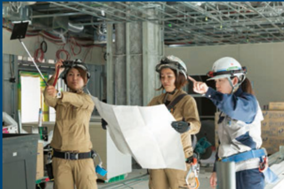
消火設備の点検は、建物の安全に関わるだけに真剣そのもの。
