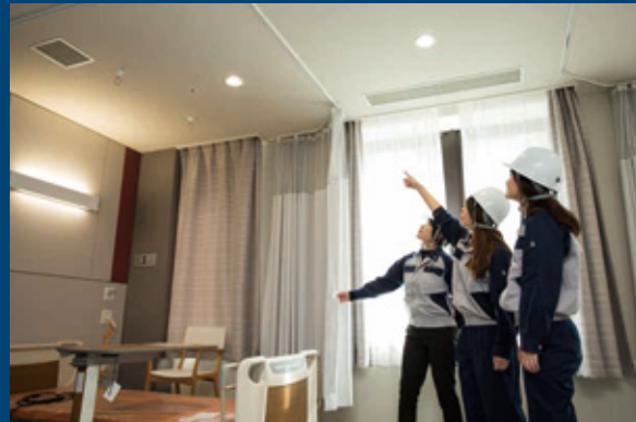
内装が図面どおりになっているかどうか、現場に出向いて確認。
