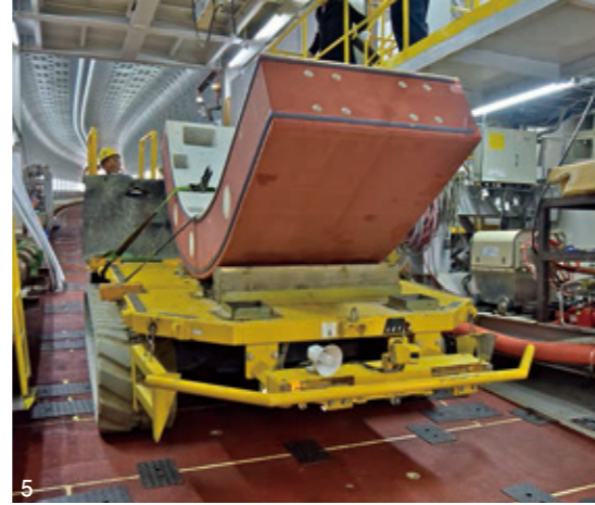
1.組み立て中の矩形シールドマシン(平成28年3月末)。2.マシンの制御室。3.矩形シールド工法で施工されているオフランプ。4.矩形シールドマシン内部。5.傾斜が急なため、セグメントの運搬車も専用のものを使っている。
