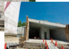
新築工事となる塔内へのアプローチ兼展示空間部分。
