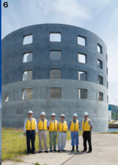
6. ケーソンは地上で製作し、海中に据え付ける。その大きさは圧巻! 7. 曲面で波を受け流しながら、波同士をぶつけて消波するシステム。8. コンクリートの色や規則正しく並んだ窓で景観にも配慮。
