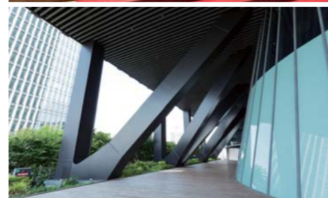
上: 中之島フェスティバルタワーの正面玄関からフェスティバルホールへ 下: メカラス構造(斜めの構造体)でフェスティバルホールの大空間を実現
