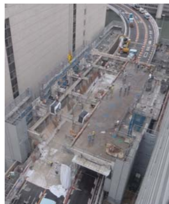
阪神高速上の既存建物解体作業
