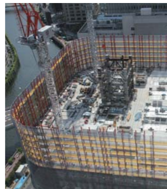
飛来落下防止のため、自動上昇養生現場の中で工事を行った
