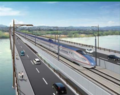
橋脚工事が行われている新九頭竜橋(仮称)の建設現場。一つの橋脚の中央部が新幹線専用橋、その両側が上下線の県道橋となる構造で、完成したら新幹線と車が並行して走る全国初の橋梁となる
