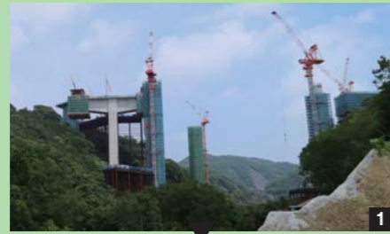
■伸びていく橋の様子
