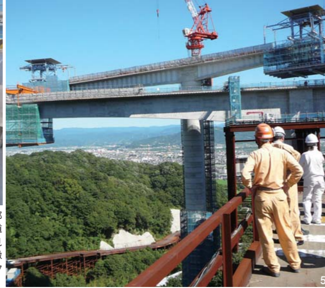
1.まさに天空に架ける橋 2.箱桁内部は空洞で軽量化されている 3.交差道路との高低差はわずか 4.橋上を見学する取材班 5.傾き、ねじれなども緻密な計算で接合・調整される 6.コンクリート打設後の現場を確認
