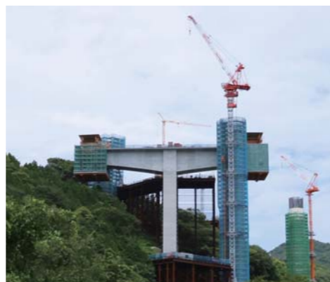
左右均等に橋を施工していく「やじろべえ工法」
