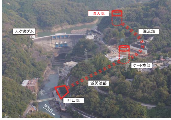
■天ヶ瀬ダム全景
