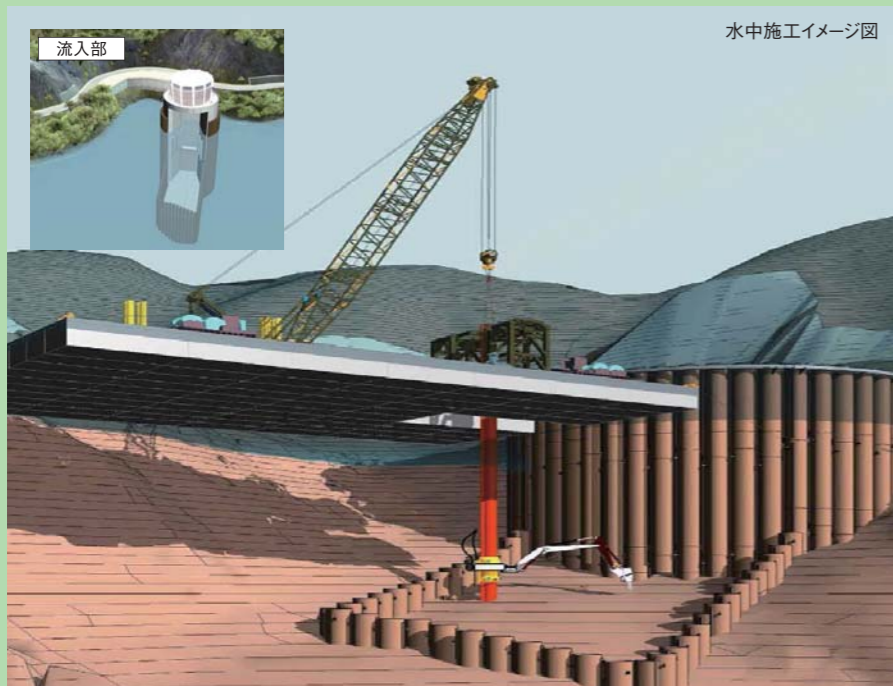
用途別にアタッチメントを駆使して遠隔操作が可能。砕岩、掘削、ズリ処理、精密測深、撮影等を水中でより確実に、スムーズに行える。
