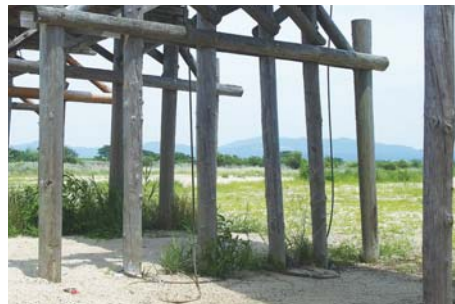
橋桁はワイヤーでつながっている
