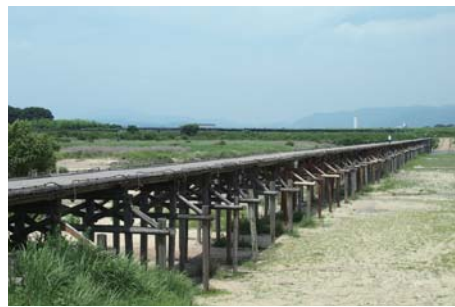
上津屋橋 (流れ橋)
