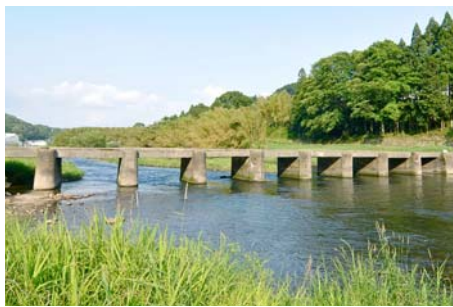
恋路橋 (沈下橋・潜水橋)
