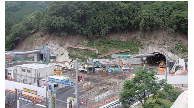
箕面トンネル工事現場全景
