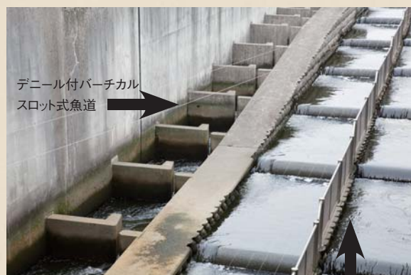
速い流れを好む魚に適した階段式魚道
