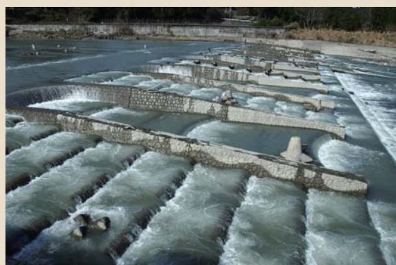
川幅全体が魚道になっている安曇川魚道堰。魚の種類・習性にあわせて13の魚道が設置されている。
