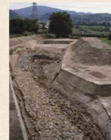
発掘された太閤堤。城の石垣を積み技術を応用した石積み護岸であることが判明。(現在は保存のため埋め戻されている)
