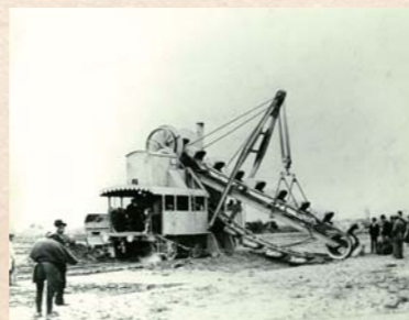
外国製の大型掘削機などで機械化を推進した。
