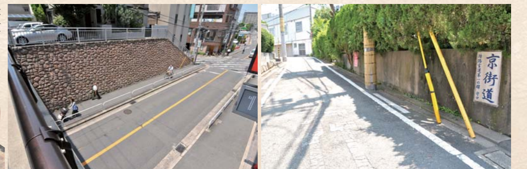
守口市内に残る文禄堤跡。道には京街道の案内板が設置されている。
