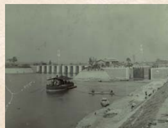
完成当時の毛馬第一閘門と洗堰
