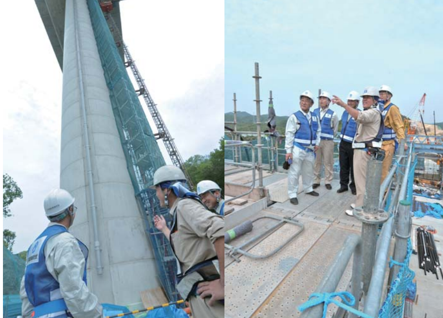
橋脚の施工方法を尋ねる取材班。
