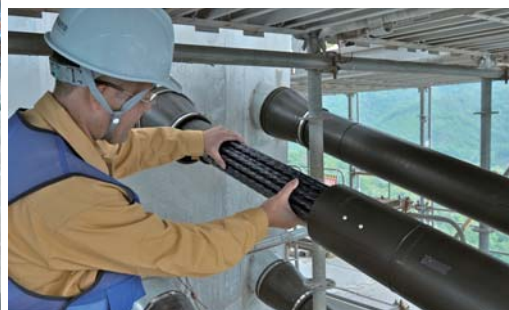
張り出された強固なケーブルを確認。
