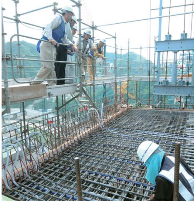
コンクリート打設準備が進む現場。
