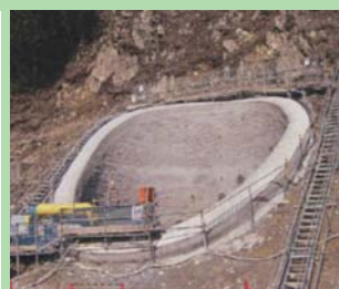
施工の様子(作業時)
