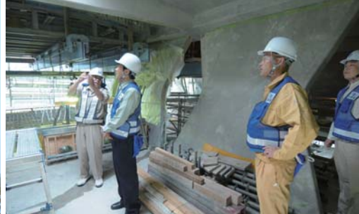
バタフライウェブが組み込まれた箱桁内を見学。
