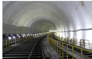
シールド工法でつくられたトンネル
