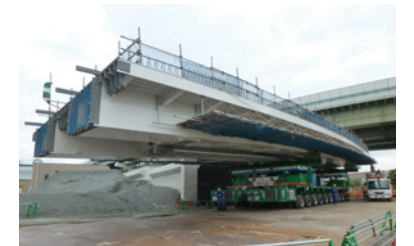
分割製作した鋼桁を特殊車両で運んで架設
