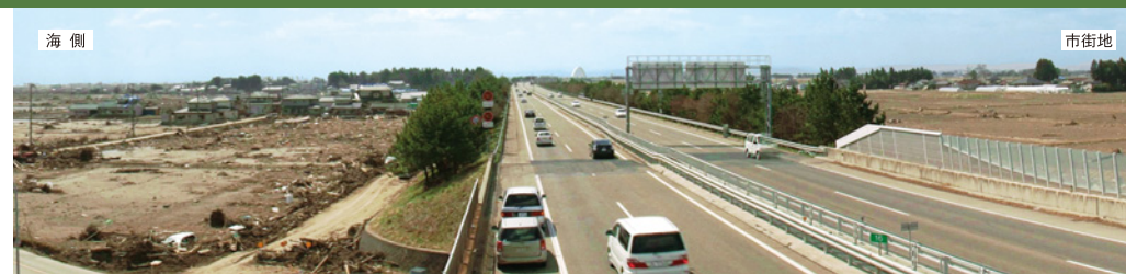
被災直後の仙台東部道路 仙台若林JCT～名取IC間 出典先:国土交通省東北地方整備局
