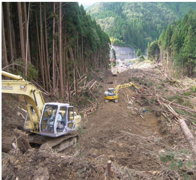
工事用道路の造成(奈良県御迫川村北股)23.10.3
