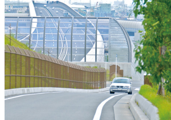
寝屋川第2トンネルの上は市民公園に。副道の道幅にもゆとりがある
