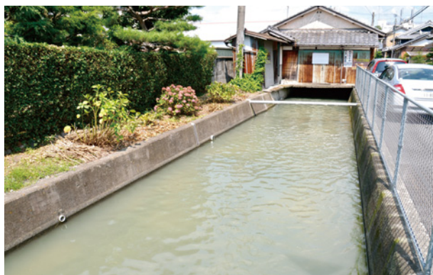
藤崎井と並行する小田井用水路。住居の下を通る場所も珍しくない
