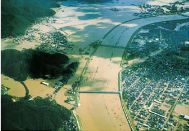
台風23号により被害を受けた円山川中流域の様子
