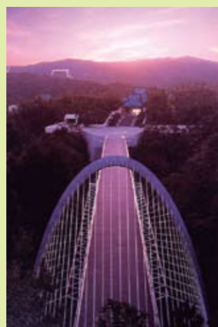
トンネル上部の山側から見た美術館の全景
