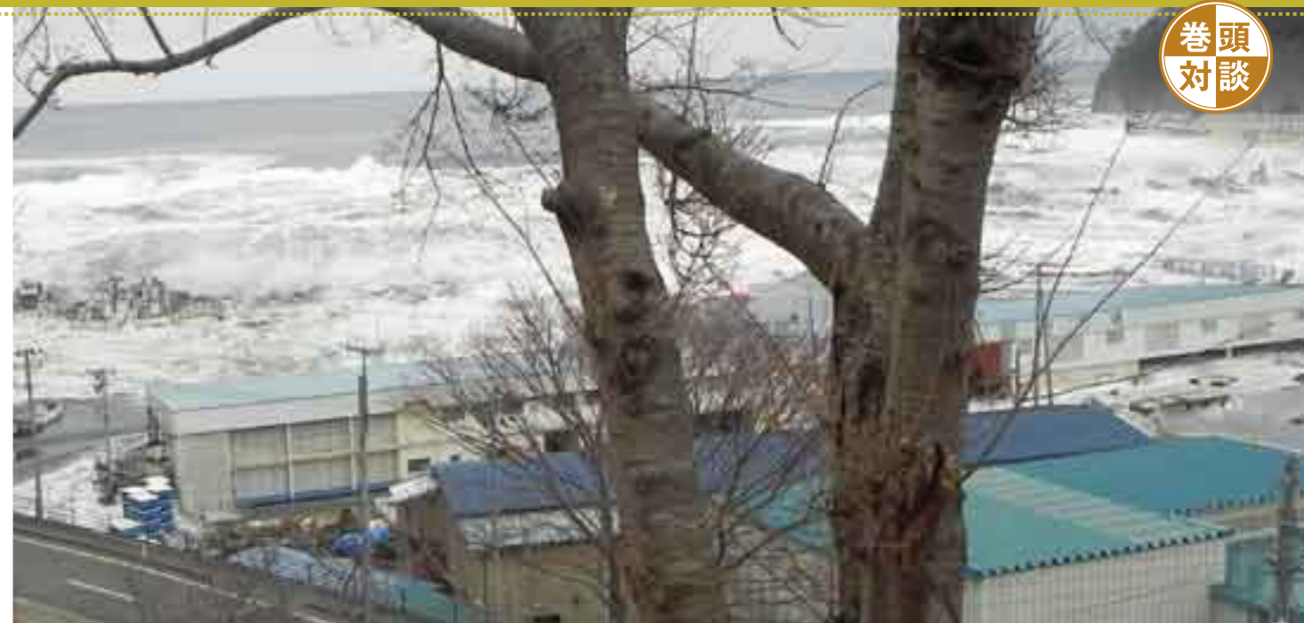
推定14メートルの津波が襲った普代村の太田名部漁港。15.5メートルの防潮堤が津波を食い止め、民家への被害を免れた。写真提供:岩手県・普代村
