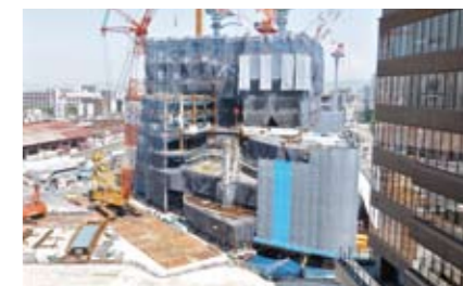
ノースゲートビルから見た工事の梅田北ヤードの様子
