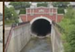
現在の新湊川トンネル
