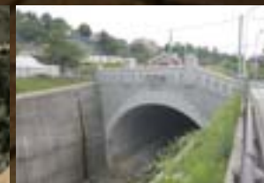
現在の新湊川トンネル
