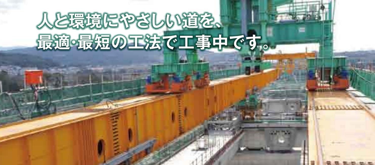
青山地区高架橋工事の桁架設状況(交野市青山地区)
