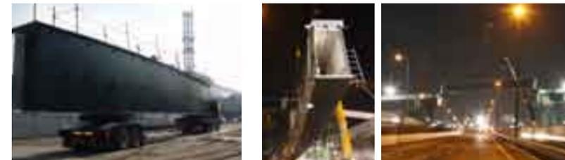
大型トレーラーで架設場所まで運搬
