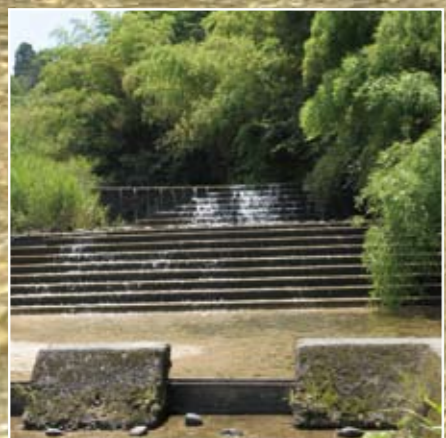
副堰堤 本堰堤の約100m下流にある副堰堤は、長さが約34m、高さが1.4m。改修前にもっと高低差があったものと推定される。
