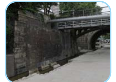
④ 時代を感じさせる、堀川第一橋 付近のレンガ積みの橋台跡
