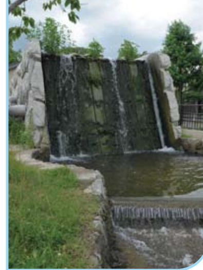
① 起点となる賀茂川サイフォン。 停電時も自家発電で水をくみ上げます。
