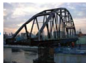
橋体を架設位置に調整しています。
