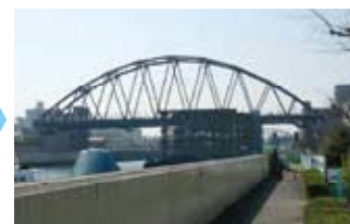
ジャッキを使用し、潮位が低下するに従い橋体重量を橋脚に荷重移動します。
