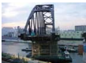
対岸への係留ワイヤー盛替え後、ウィンチとタグボートを併用し、台船移動・回転を行っています。
