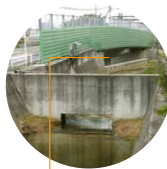
増水時は、手前の堤防で流量を調整し、越流させるしくみです。
