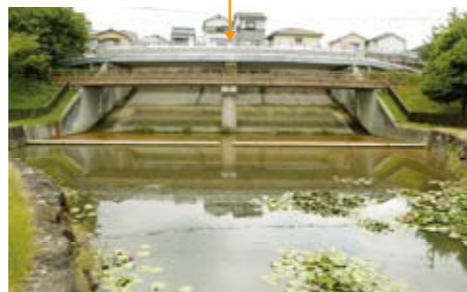
増水時は、手前の堤防で流量を調整し、越流させるしくみです。
