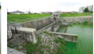
水量を調節する常用洪水吐(東除)
