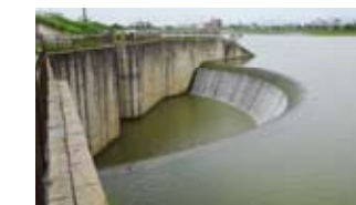
水量を調節する常用洪水吐(西除)
