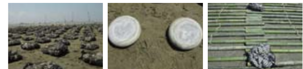
フィルターユニット 転石ブロック 竹沈床
