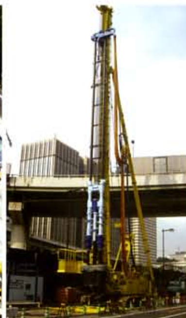
くい打ち工事
