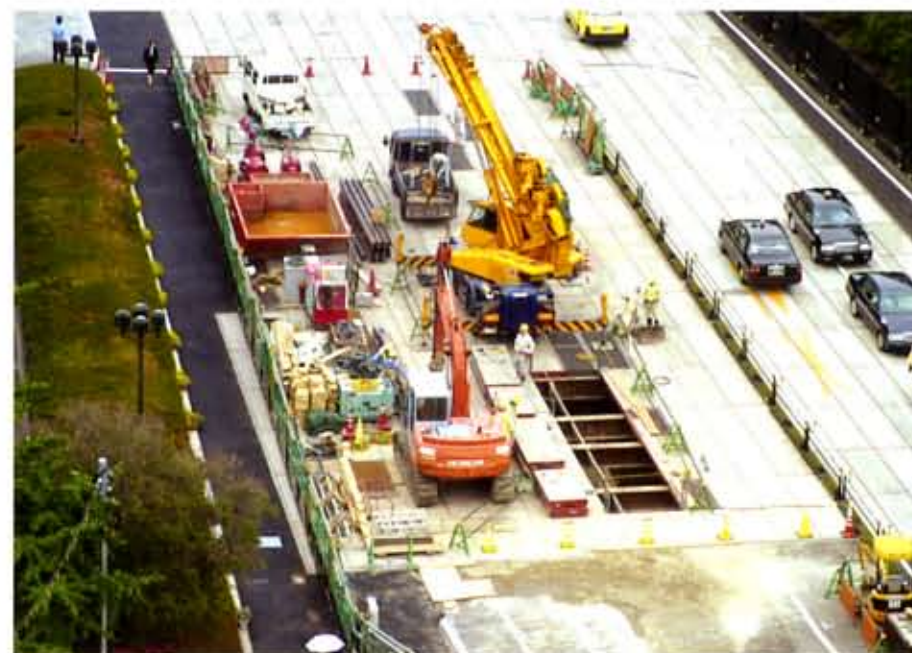
工事現場鳥瞰
