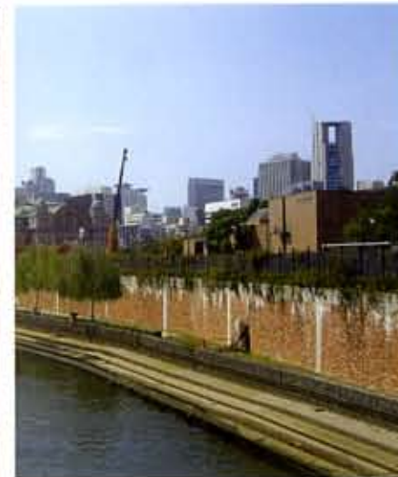
レンガで装飾された仮囲
