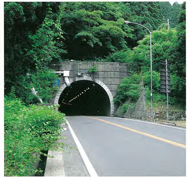
●青葉トンネル(吉坂峠)
