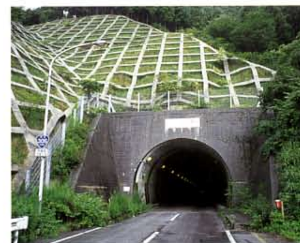
鞍掛トンネル
