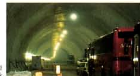
片側3車線の超大断面トンネル
