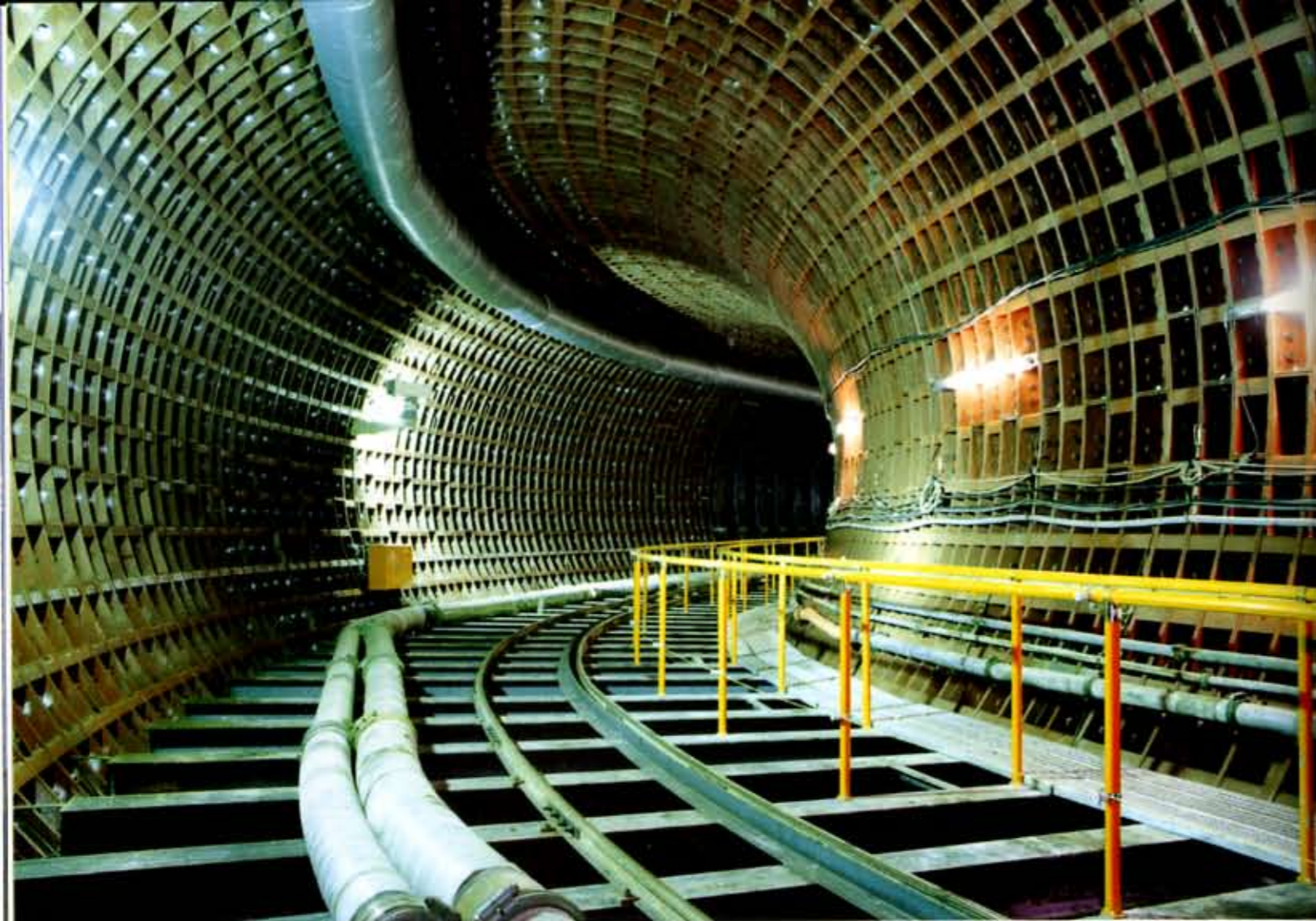
一次掘削が完成したシールドトンネル(仕上がり内径6.5m)
