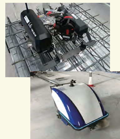
建設現場でのロボットの活用
