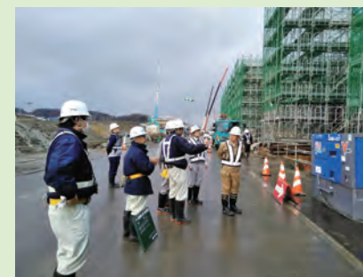
現場点検の様子
