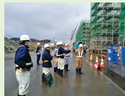
現場点検の様子
