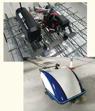
建設現場でのロボットの活用
