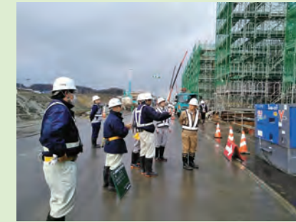
現場点検の様子
