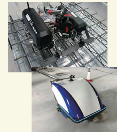
建設現場でのロボットの活用
