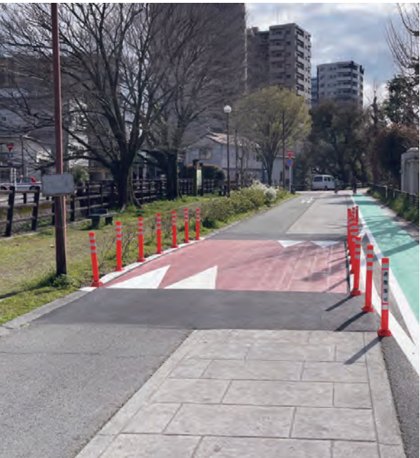
ハンプ設置状況(中央区新屋敷1丁目地区)
