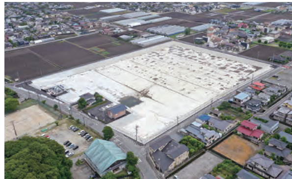
坪井川第3排水区雨水調整池
