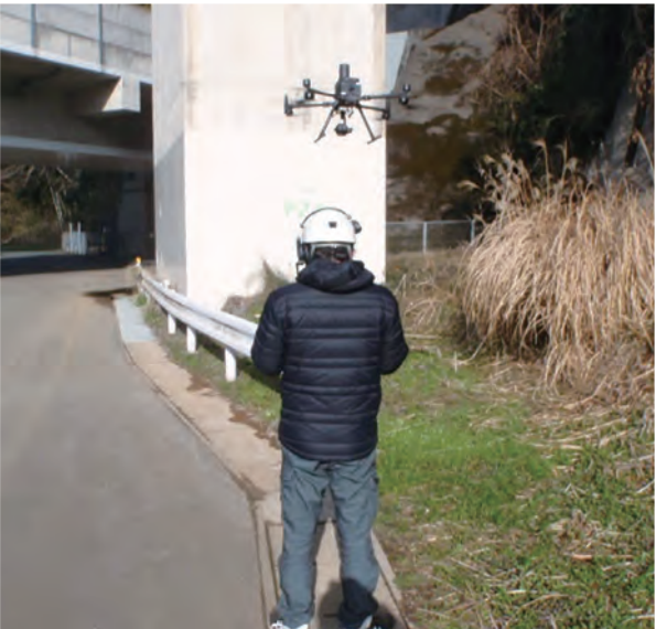
ドローンを用いた橋梁点検
