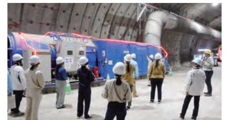
トンネル内を歩いて工事の様子を見学。
