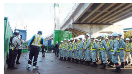
大きな橋桁が並ぶ現場にみんな興味津々。
