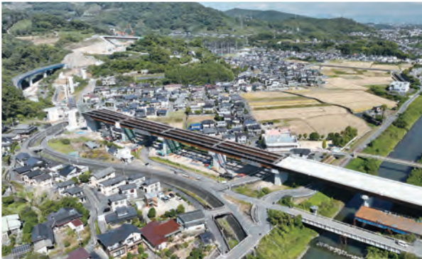
池上IC工事状況(R5.10時点)
