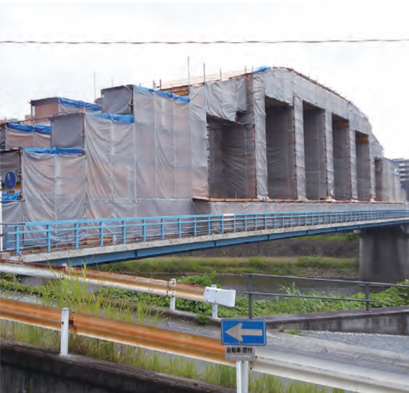
安巳橋(あんせいはし)補修工事状況
