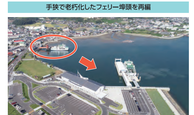
口ノ津港航空写真(令和2年10月撮影)
